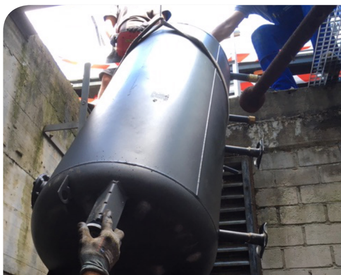
Erst der Ausbau des alten Wärmespeiches ...
