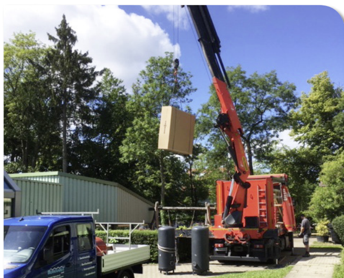
... und dann werden Teile der neuen Heizung geliefert.
